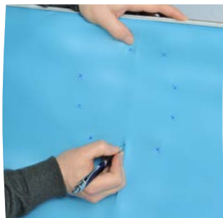
Individuare e segnalare la posizione delle viti
