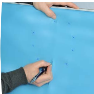
Localize e assinale a localização dos parafusos
