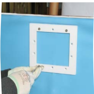
Schrauben Sie den Flansch fest und sparen Sie den Liner aus
