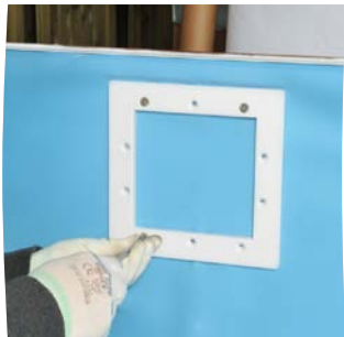
Avvitare il traversino e togliere il liner
