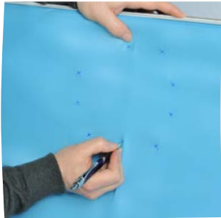
Repérez et tracez l'emplacement des vis
