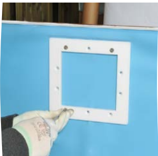
Aparafuse o flange e aligeire o liner
