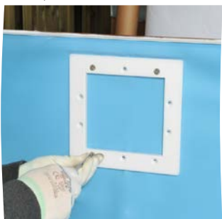
Atornille la brida y ahueque el liner
