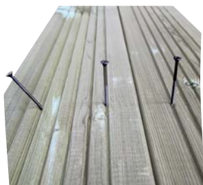
Fixing of the edges Colocación de las playas Fixation des margelles Befestigung der Ränder Fissaggio dei bordi Bevestiging van de randen Fixação dos bordos
