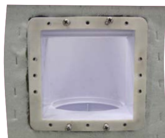
Fixing of the skimmer joint Fijación de la primera junta del skimmer Fixation du 1er joint de skimmer Befestigung der ersten Dichtung des Skimmers Fissaggio del primo giunto dello skimmer Bevestiging van de eerste pakking van de skimmer Fixação da primeira junta do skimmer
