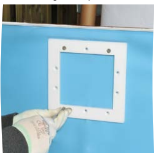
Avvitare il traversino e togliere il liner
