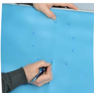
Repérez et tracez l'emplacement des vis
