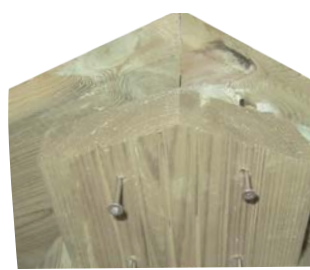
Fixing of the plates Fijación de los tacos bajo las placas Fixation de la plaque sous margelles Befestigung der Platten unter den Rändern Fissaggio delle piastre sotto i bordi Bevestiging van de platen onder de randen Fixação das placas sob os bordos
