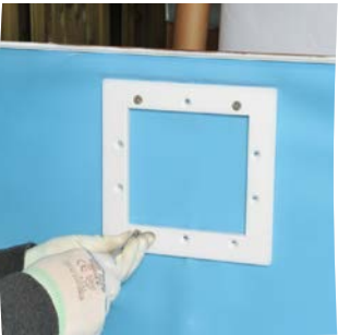
Schroef de flens vast en snijd de liner aan binnenzijde ervan los
