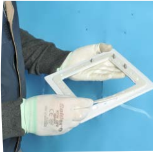
Setzen Sie die Dichtung auf den Flansch
