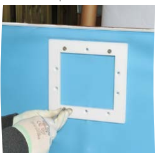
Aparafuse o flange e aligeire o liner
