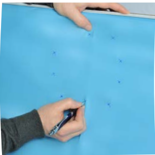
Repérez et tracez l'emplacement des vis
