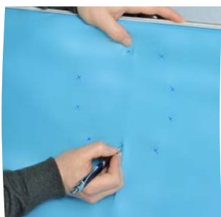
Individuare e segnalare la posizione delle viti
