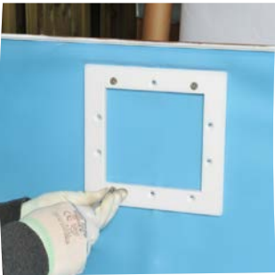
Atornille la brida y ahueque el liner
