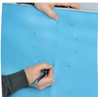
Localize e assinale a localização dos parafusos
