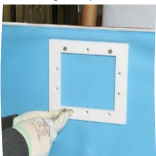
Avvitare il traversino e togliere il liner
