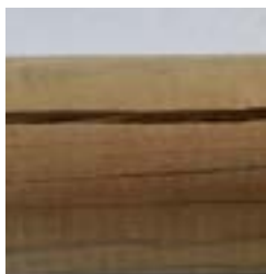
Cracks/Grietas/Fente/Risse/ Crepe/ Barsten/Fendas
