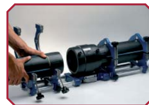
Después de colocar la abrazadera, deslizar el manguito sobre el tubo. Extraer el manguito del embalaje inmediatamente antes de la fijación. No tocar las superficies exteriores ni interiores de los tubos limpios ni de los manguitos con los dedos.
