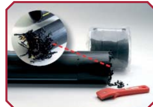
Raper la superficie de la zone de soudure avec un couteau ou un outil approprié.
